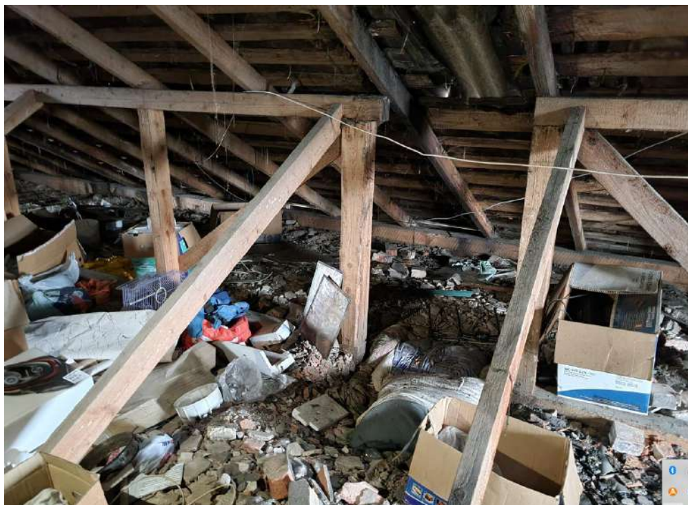
1.5 pav. stogo konstrukcijų ir pastogės fotofiksacija
