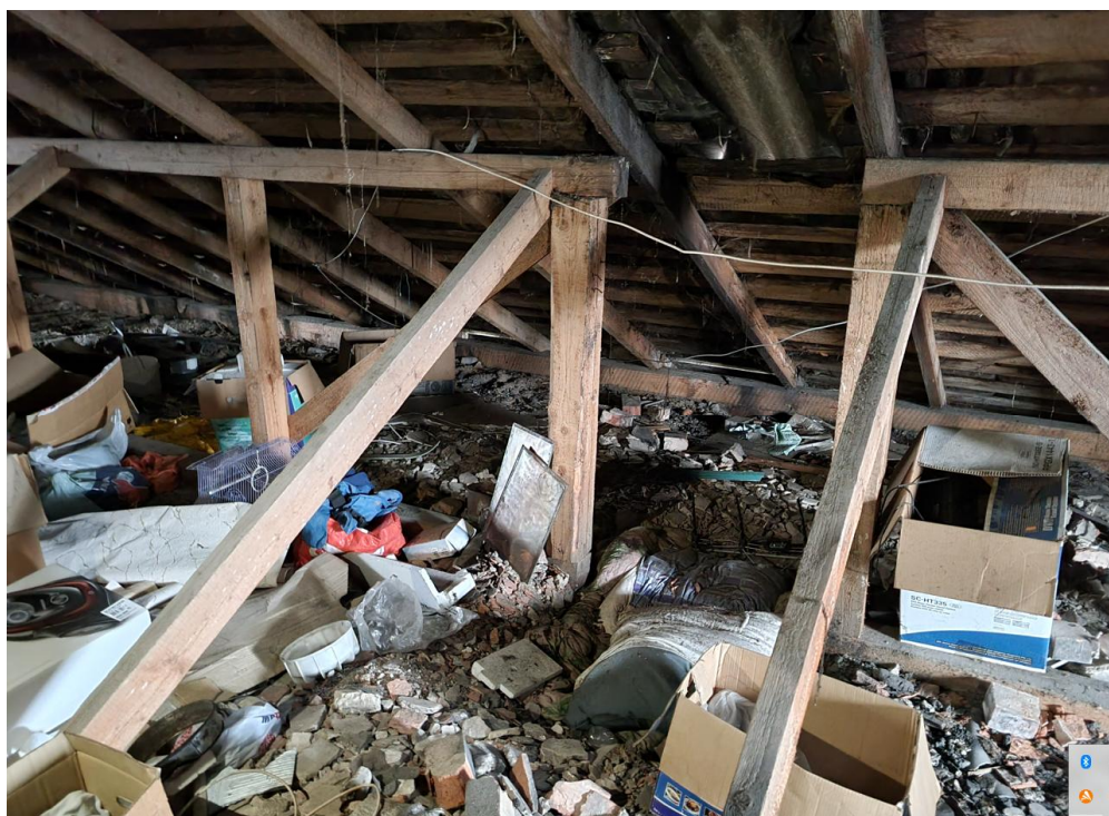
1.5 pav. stogo konstrukcijų ir pastogės fotofiksacija
